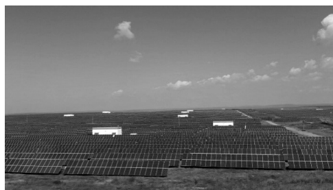
Рис. 4. Солнечные электростанции в Дербетском хошуне, сентябрь 2014 г.
